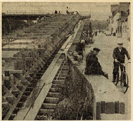
AUSGESCHALTET wurde teilweise die neue Fußgängerüberführung über die künftige Ortsumgehung Nackenheim. Der rheinseitige Aufgang ist schon betoniert. Die Überführung soll insbesondere auch bei hohem Wasserstand einen Zugang zur Nachenstraße sicherstellen. Die Arbeiten zu dieser Brücke haben im Frühjahr dieses Jahres begonnen.
